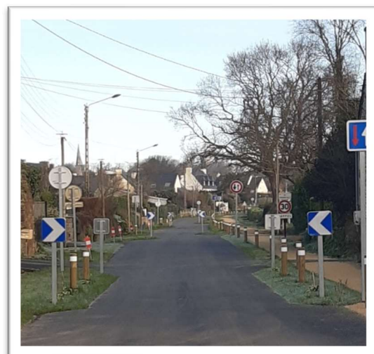
Après les travaux
